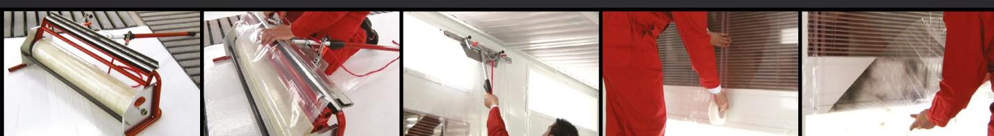
Film4Booth – 4-х слойная защитная пленка для нанесения на стены в покрасочной камере. Пленка самоклеющаяся и прозрачная. Обработана особым липким покрытием. Срок использования каждого слоя – 250 циклов покраски или 3 месяца. Для обновления пленки необходимо снять верхний слой, просто потянув за край пленки, и проклеить стыки липкой лентой. Самое лучшее и простое решение сохранить покрасочную камеру новой навсегда!
