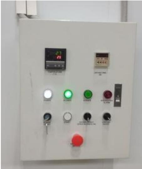
4. Контроллерная система с максимальной точностью поддерживает рабочие режимы. Система позволяет программировать рабочие режимы для различных типов лакокрасочных материалов по параметрам температуры и времени сушки. Автоматы, контакторы(электромагнитные пускатели), температурный контроллер, контроллер времени, все детали в случае выхода из строя можно оперативно поменять, так как имеются в свободной продаже у
