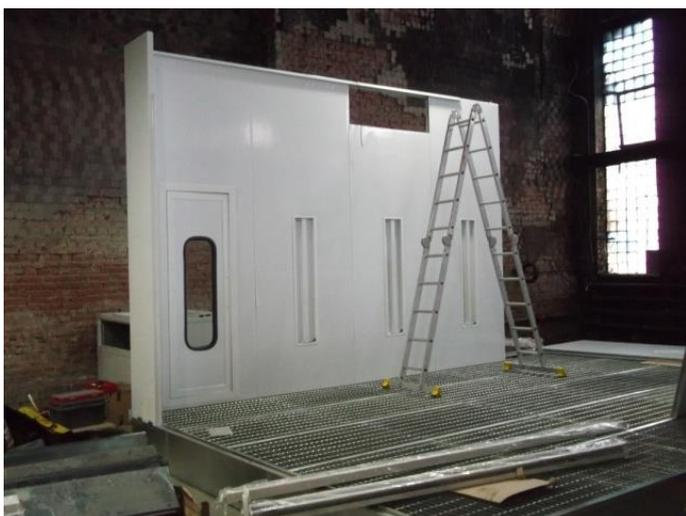
1. Корпус камеры выполнен из сэндвич-панелей толщиной 50 мм, выполненные по схеме шип-паз, изготовленные из оцинкованной листовой стали, покрытой полимерной антибликовой краской.
