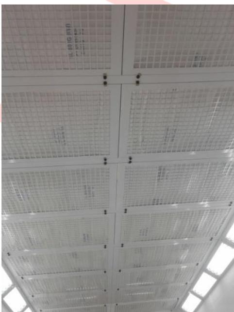
11. Фильтра тонкой очистки, закрепленные в удобных для замены, откидывающихся на петлях рамках, расположены по всей площади потолка, что обеспечивает равномерность исходящего воздушного потока.
